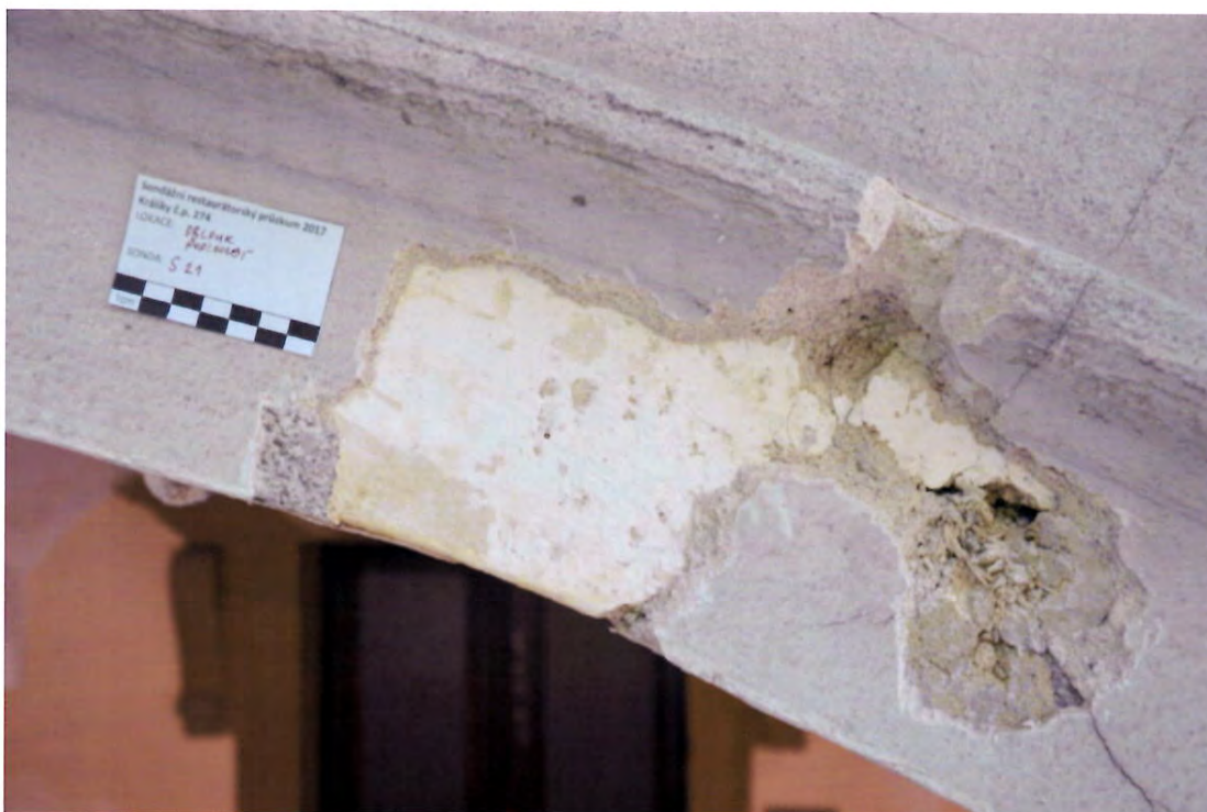
Obr. 21 Nejstarší dochovaná omítka s barevnou vrstvou v oblouku podloubí.
