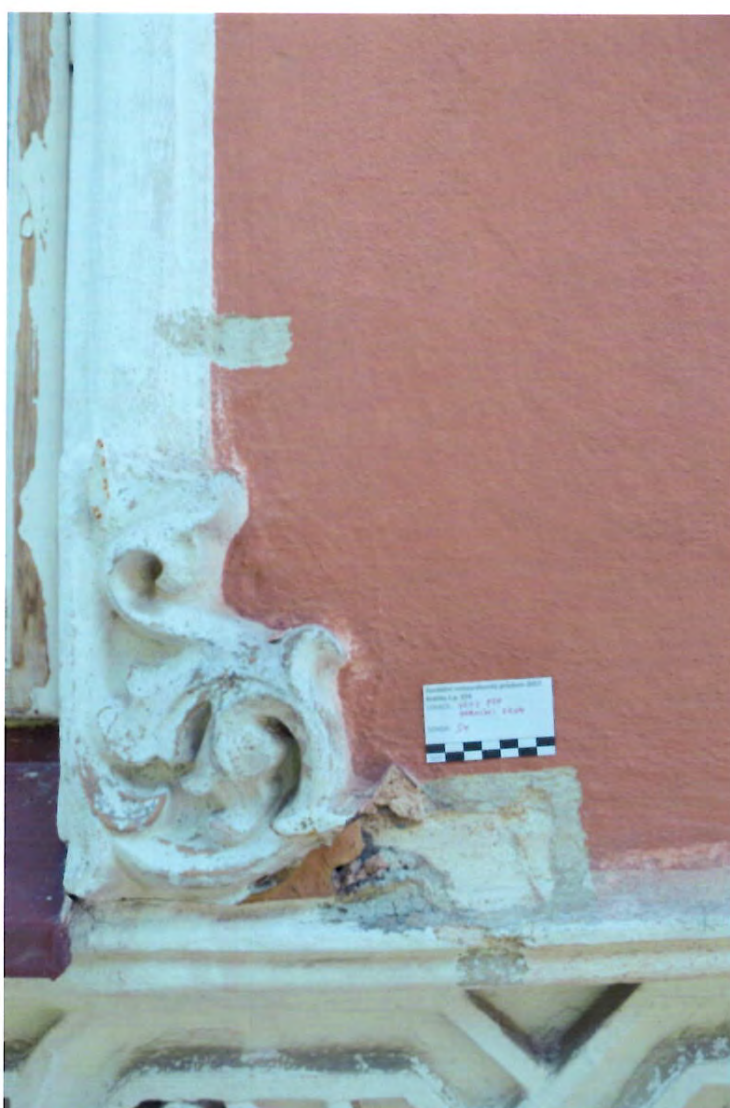
Obr. 13 nahoře Sonda 174/S4. Detail povrchové úpravy prefabrikátu z pálené hlíny? Pod prefabrikátem se nalézá silné souvrství starších nátěrů, včetně nejstaršího, na fasádě doloženého typu omítky.
