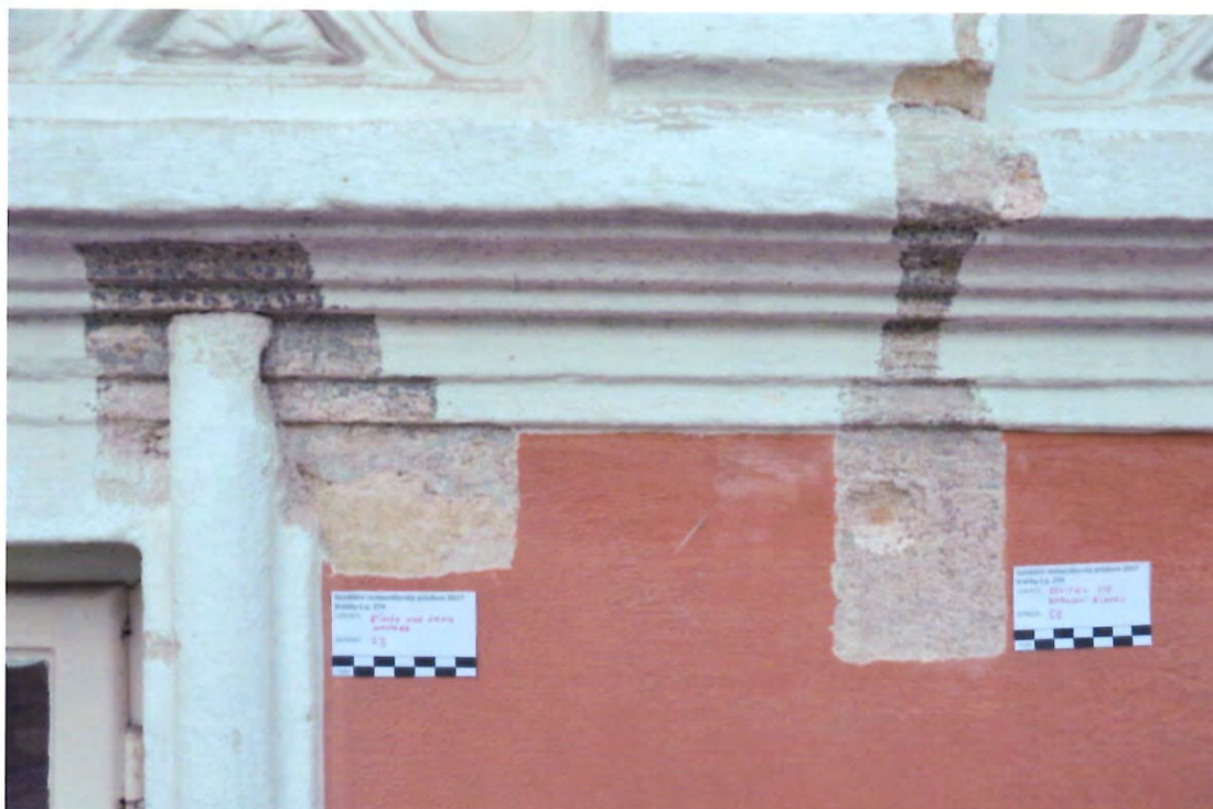
Obr. 11 nahoře Sonda 274/S3. Římsa probíhá i pod patrně mladší šambránou okna druhého patra. Pod štukovou šambránou se nalézá souvrství starších nátěrů, na šambráně samotné je nanesen pouze bílý nátěr.
