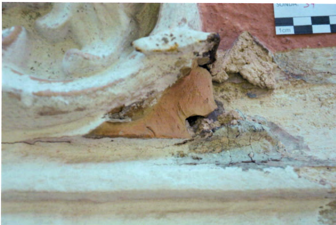
Obr. 13 nahoře Sonda 174/S4. Detail povrchové úpravy prefabrikátu z pálené hlíny? Pod prefabrikátem se nalézá silné souvrství starších nátěrů, včetně nejstaršího, na fasádě doloženého typu omítky.
