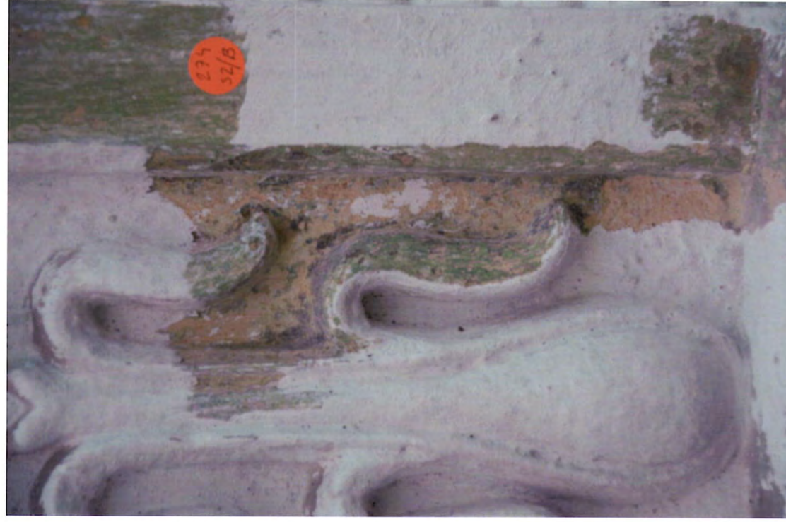
Obr. 10 Sonda 274/S2B. Detail povrchové úpravy odlitku.
