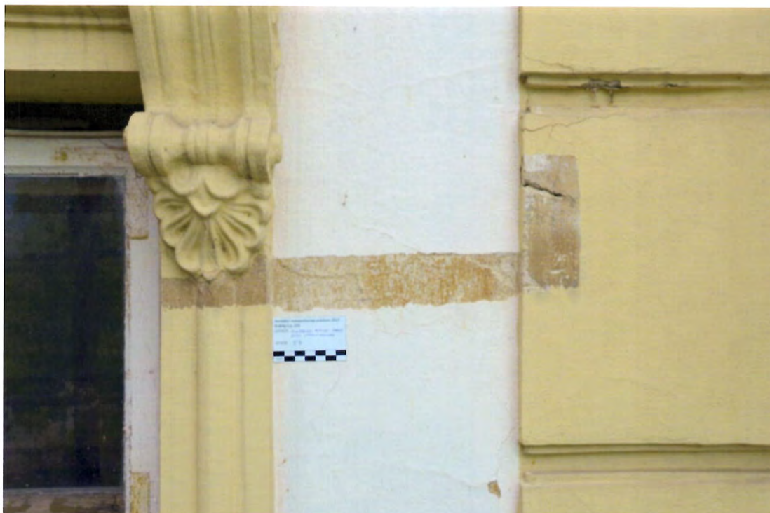
Obr. 27 První dochovaná barevná úprava na fasádě domu.
