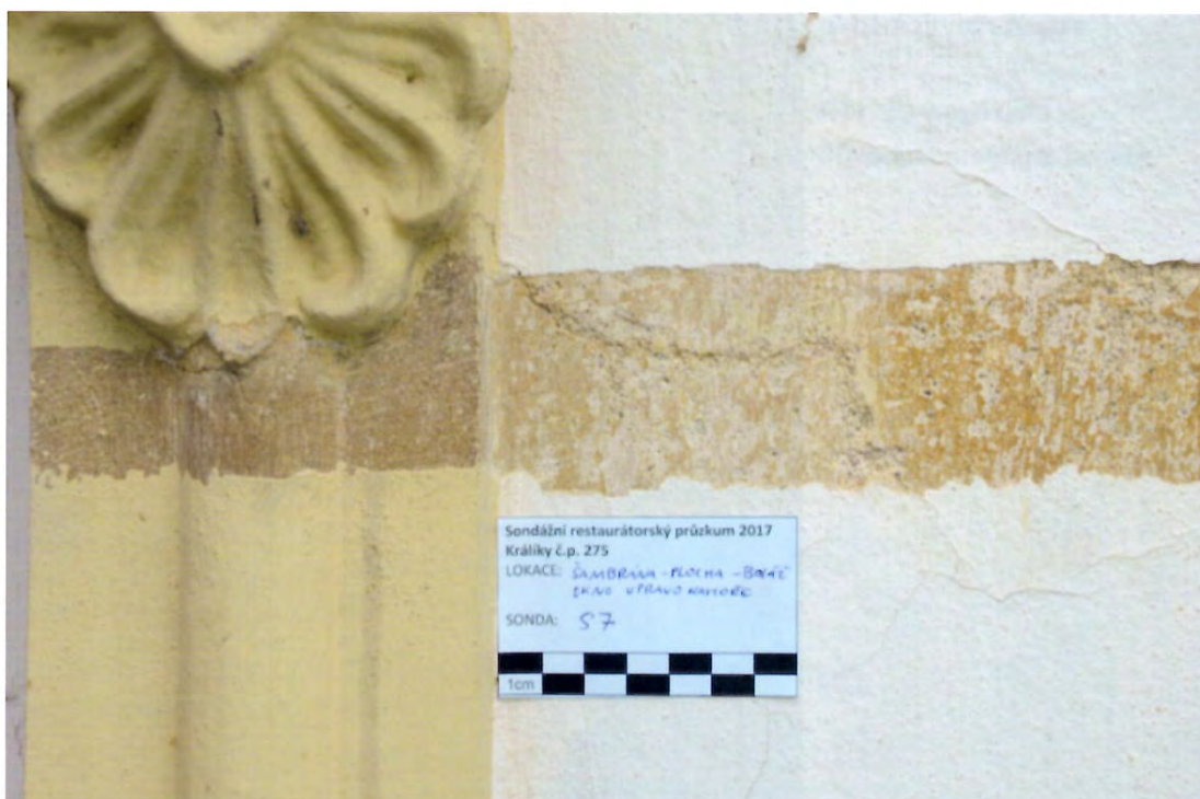
Obr. 28 Detailní snímek. První dochovaná barevná úprava na fasádě domu.
