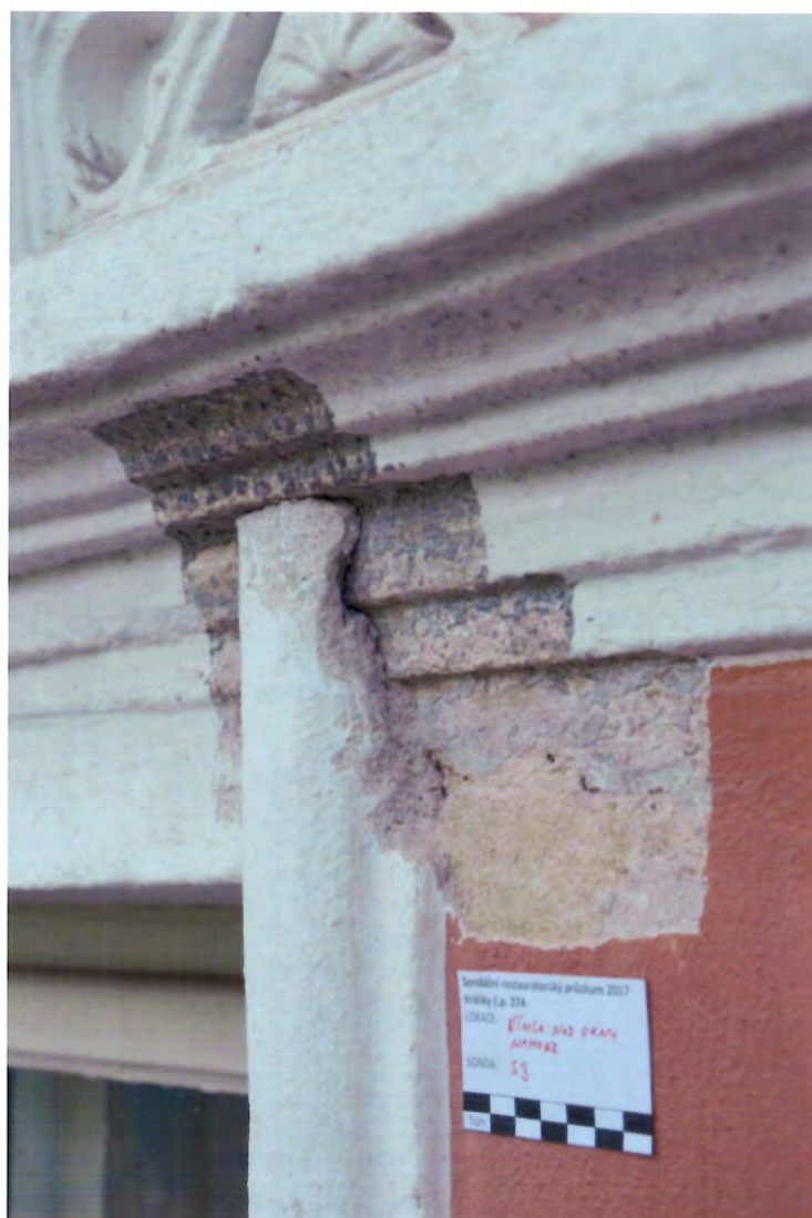
Obr. 11 nahoře Sonda 274/S3. Římsa probíhá i pod patrně mladší šambránou okna druhého patra. Pod štukovou šambránou se nalézá souvrství starších nátěrů, na šambráně samotné je nanesen pouze bílý nátěr.
