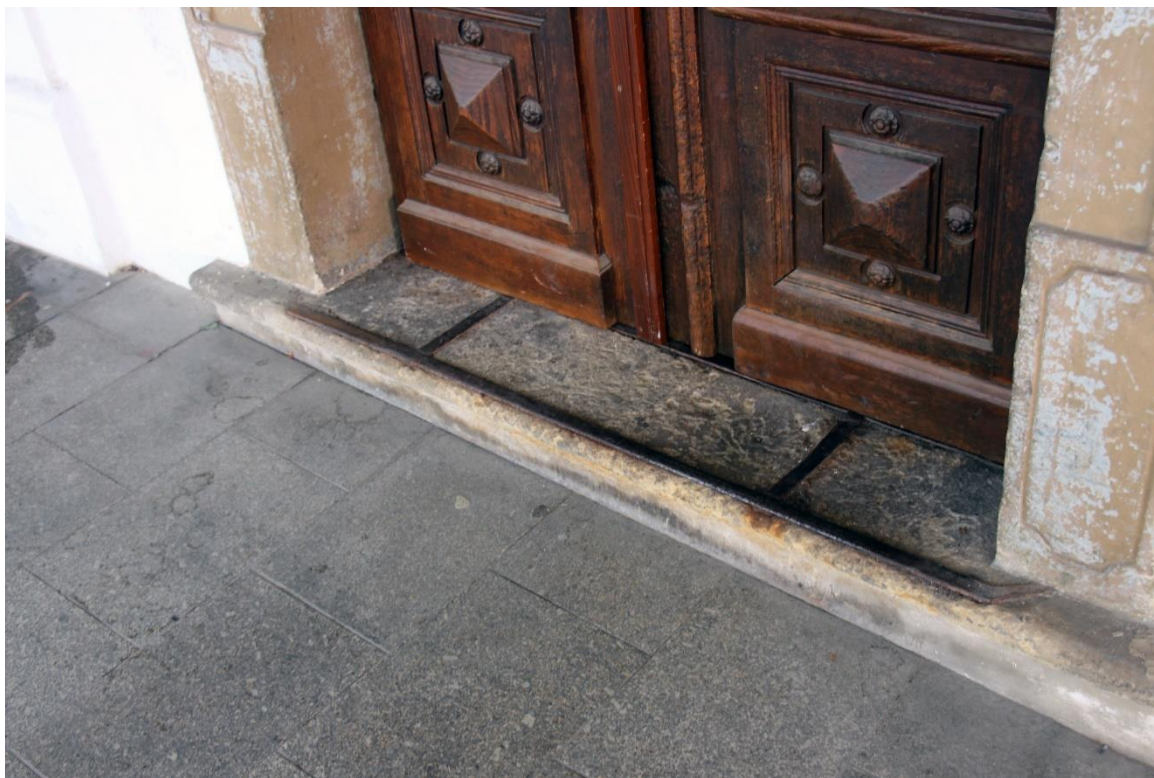
Obrázek 9 Detail kovové konstrukce - práh
