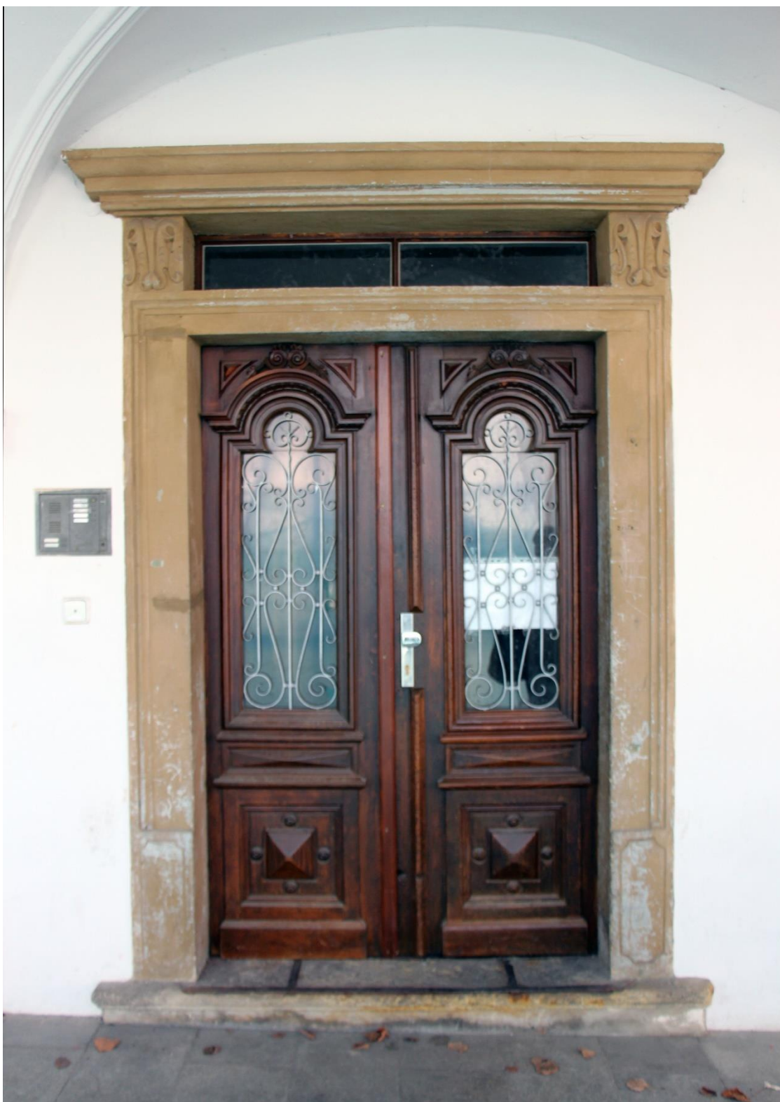
Obrázek 5 Stav objektu - celkový pohled
